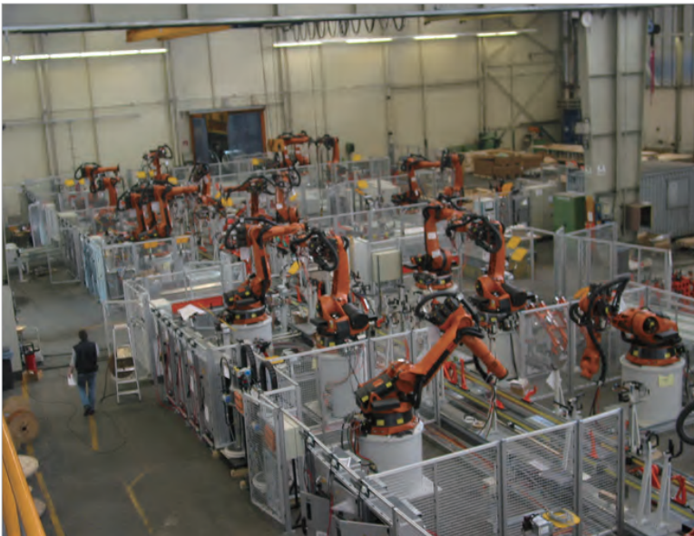
그림 11-2 공간분리형 로봇의 설치 운영 사례 ( http://www.robotunits.com.au/category/safety-fencing/ )
